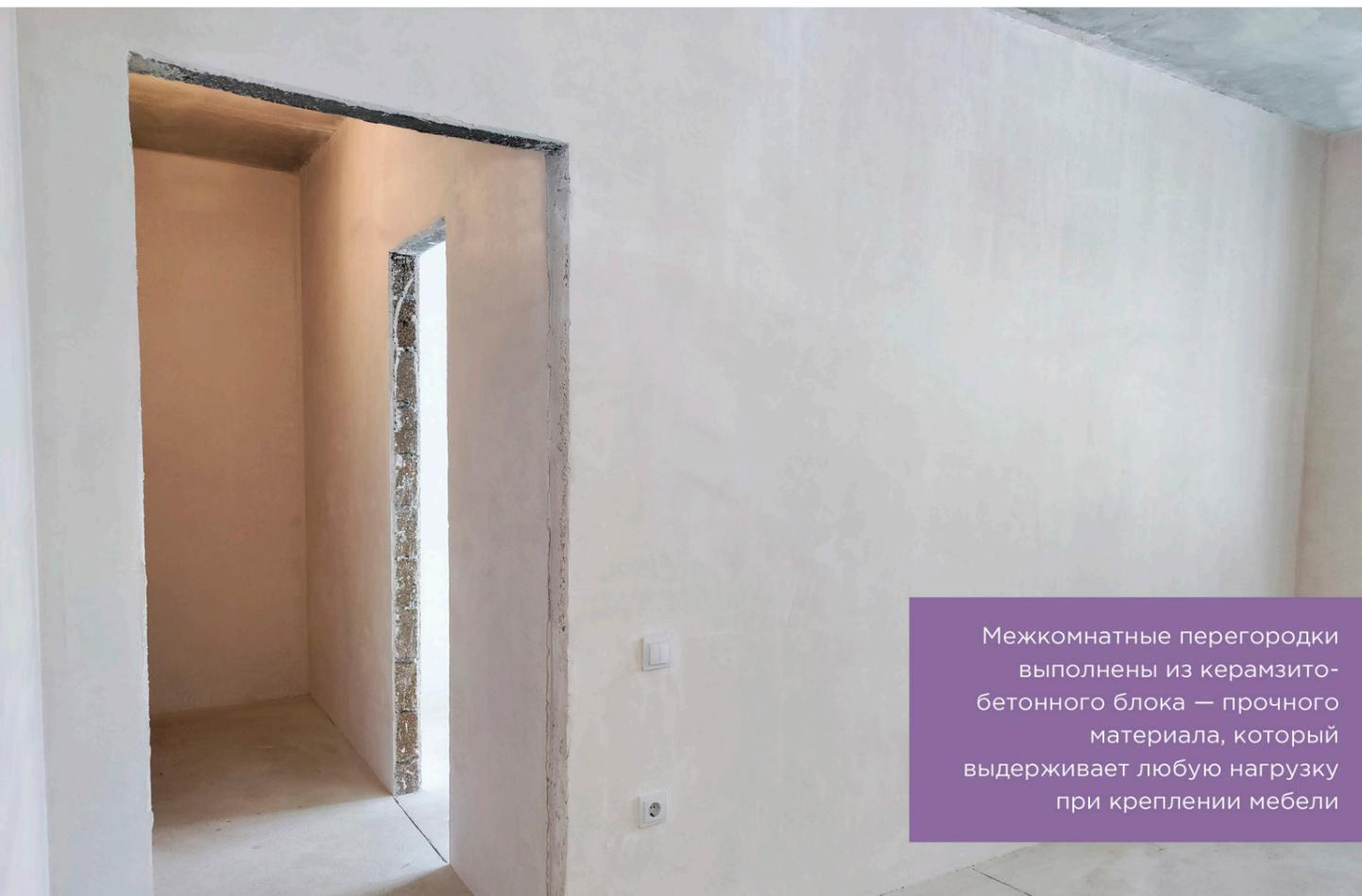
Межкомнатные перегородки выполнены из керамзитобетонного блока — прочного материала, который выдерживает любую нагрузку при креплении мебели
