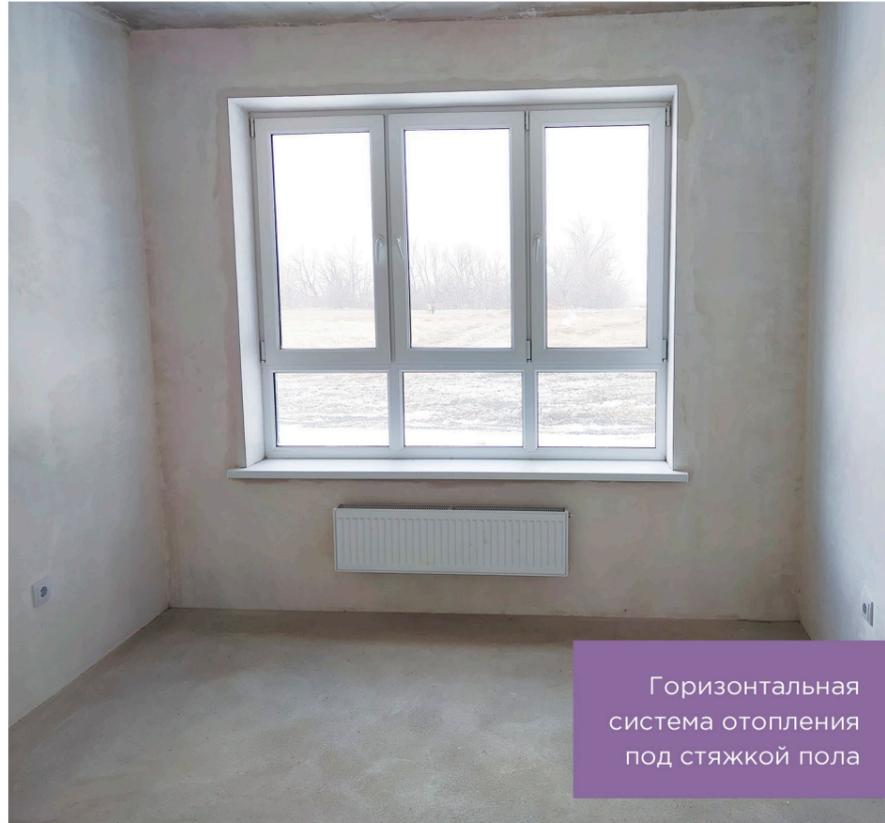
Горизонтальная система отопления под стяжкой пола
