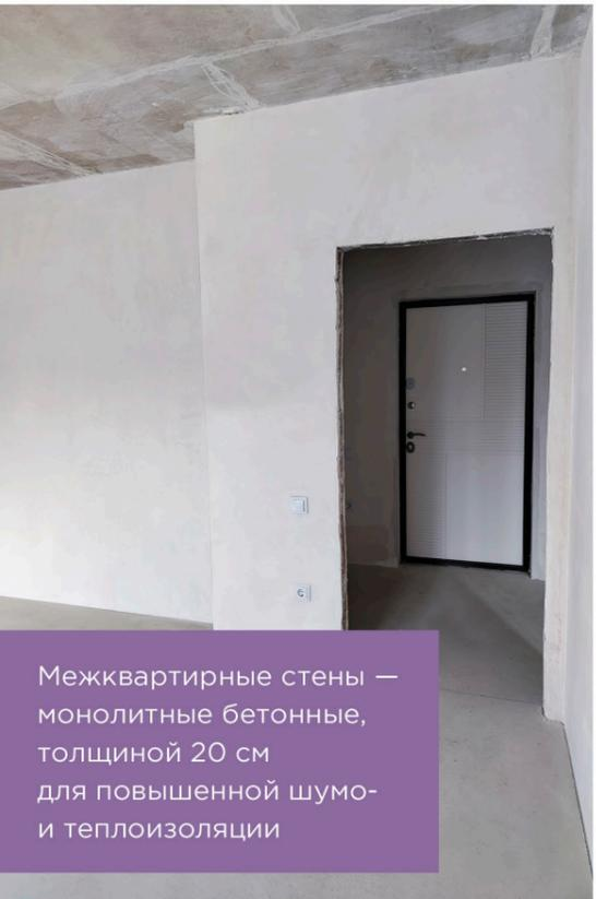
Межквартирные стены — монолитные бетонные, толщиной 20 см для повышенной шумо- и теплоизоляции
